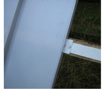
Montage Soganker, Paneel, Unterkonstruktion mit PE-Zellband
