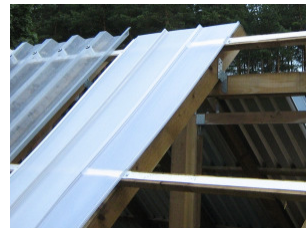
Unterkonstruktion beklebt mit PE-Zellband
