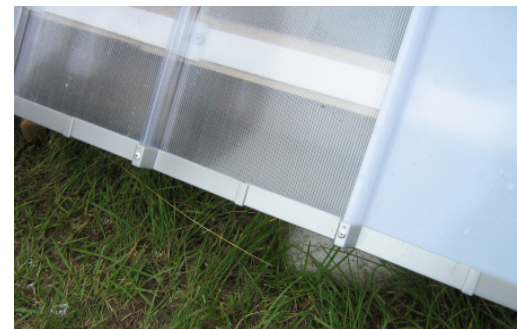
Traufe, Abdeckkappen mit Becherblindnieten befestigt
